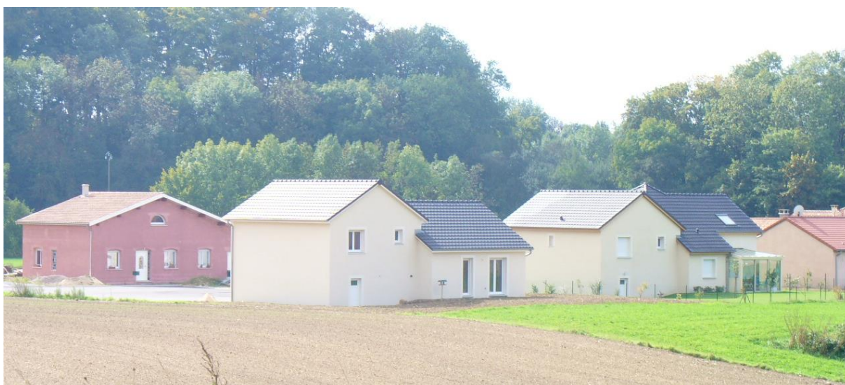
Diversité des toitures dans un lotissement récent à DIEUE-SUR-MEUSE.
